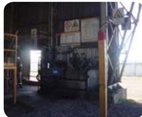
Simulacro de emergencia ambiental en central hidráulica
